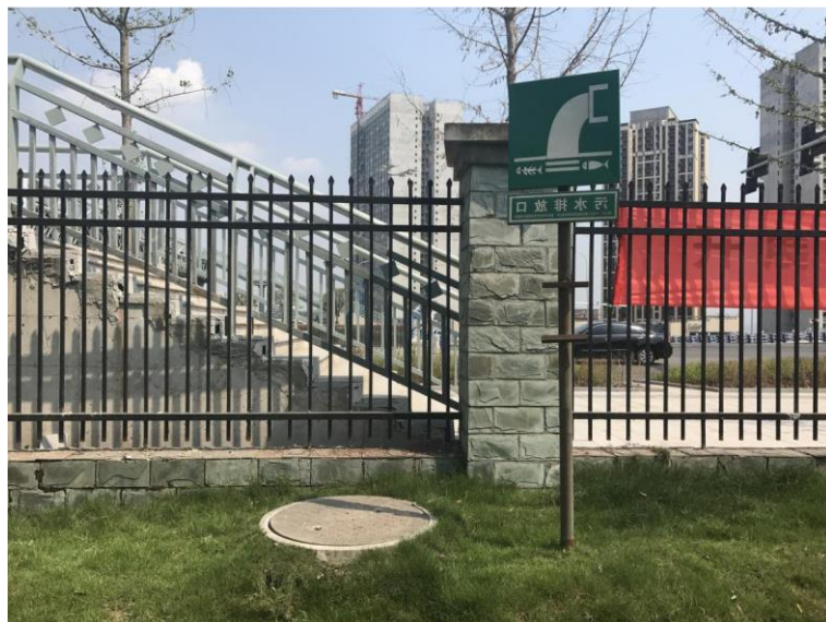
1#污水处理设施
